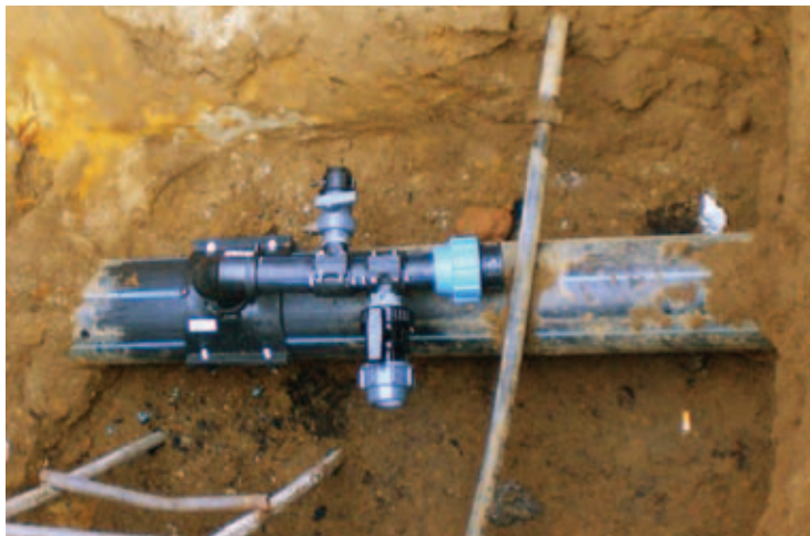
Пример врезки в действующий трубопровод
